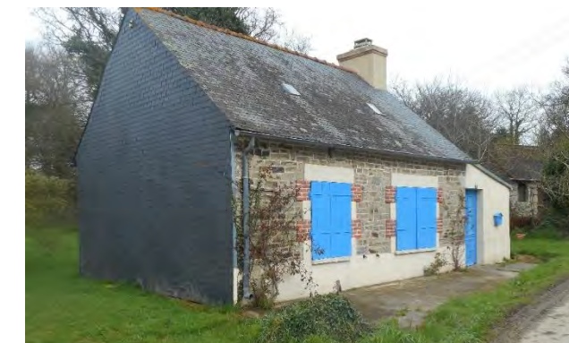
Figure 78 : Maison traditionnelle à Saint-Lubin (© ATER Environnement, 2018)
