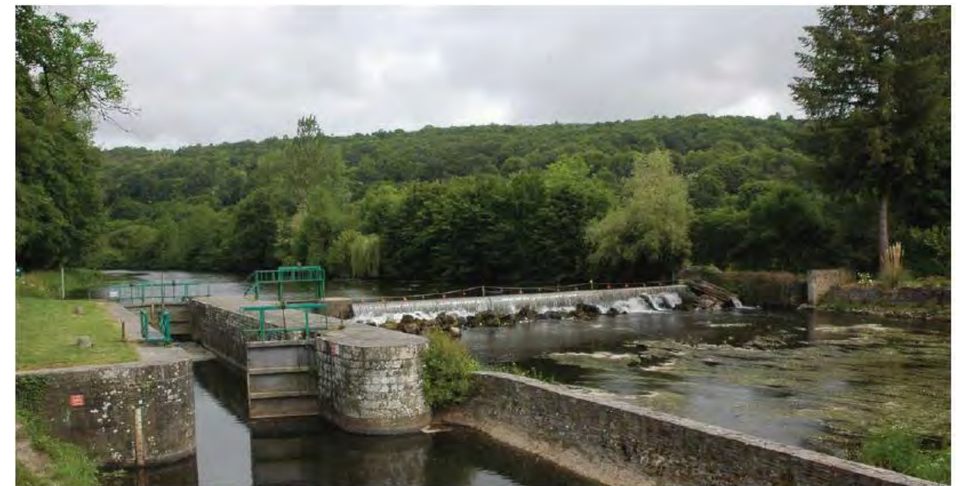
Figure 53 : Écluse le long du Blavet (portion du Canal de Nantes à Brest) au Sud-Est de Gouarec (source : SARL Laurent Coüasnon, 2018)
