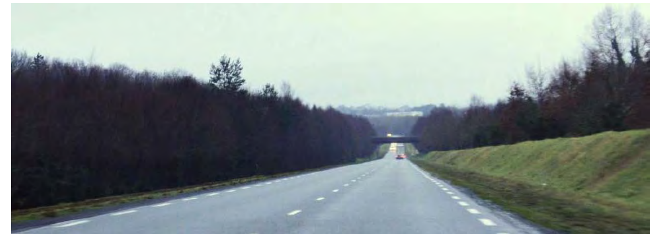
Figure 61 : Vue cadrée dans l'axe de la voie (RN 164) par des talus surmontés de haies à l'approche de Rostrenen (source : SARL Laurent Coüason, 2018)
